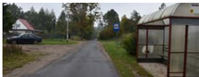
W budżecie powiatu 600 000 zł przeznaczono na dalszą przebudowę drogi Bobięcino - Małęcino w gminie Miastko.
