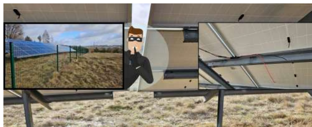
Przy Szkole Podstawowej nr 3 w Miastku doszło do próby kradzieży paneli fotowoltaicznych. Uszkodzona została instalacja i ogrodzenie
