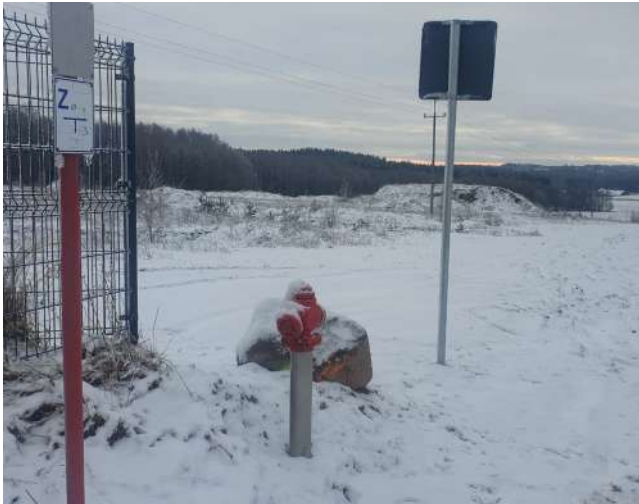
Wodociągi wydały ponad milion złotych, aby zbudować tzw. bypass. Rura przebiega obok działek burmistrza i jego wspólnika
