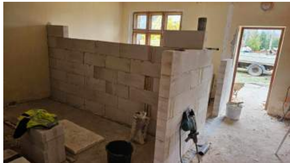
Trwają intensywne prace przy budowie ośrodka "U Pirata II" w Bobięcinie
