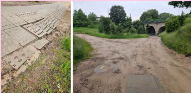
Końcowy odcinek ulicy Kąpielowej zostanie zmodernizowany wspólnie przez gminę Bytów i powiat bytowski
