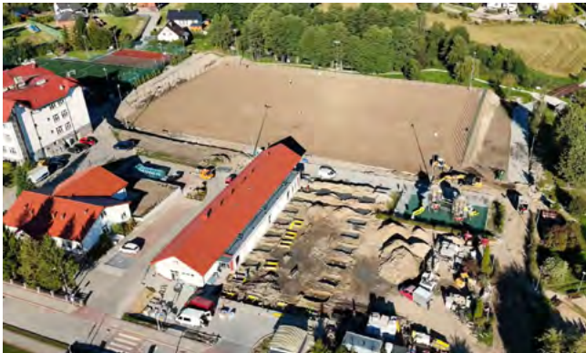
Rozpoczęła się już budowa hali Olimpia
