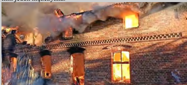
W piątek 26 września w Udorpiu doszło do pożaru budynku mieszkalnego, użytkowanego przez jednego mężczyznę
